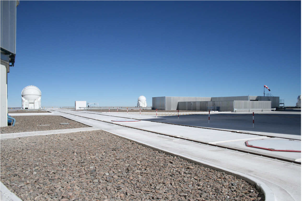
Figura 154 - Outra vista do VLT, onde é possível ver um dos telescópios de 8,20 m de diâmetro (cortado, à esquerda), dois telescópios móveis de 1,80 m de diâmetro e o edifício do interferômetro, onde é combinada a luz proveniente dos diversos telescópios. Foto: Francisco Conte.
