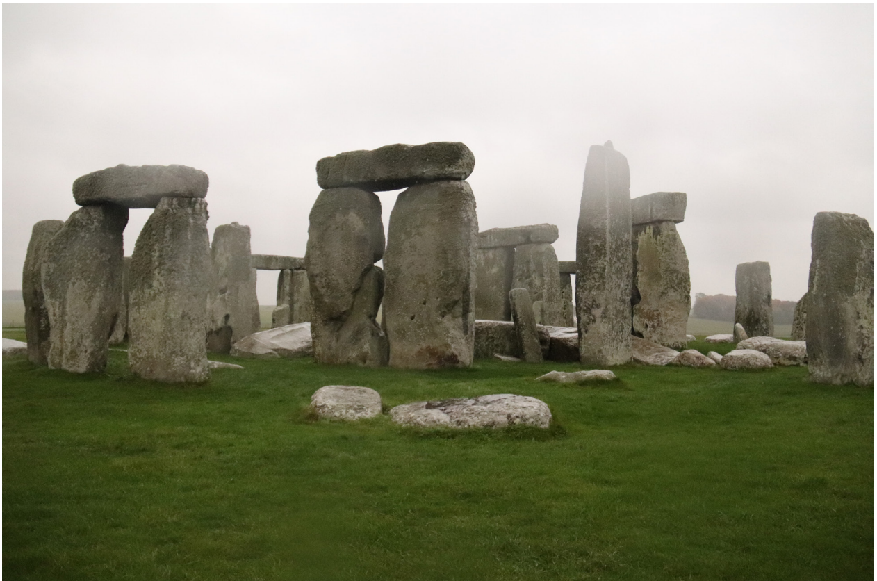
Figura 1 - Stonehenge: monumento pré-histórico localizado no sul da Inglaterra. A construção, composta de pilares e vigas de pedra formando pórticos em uma disposição circular, tem 33 m de diâmetro, com pilares que chegam a 4 m de altura e a 25 toneladas de peso. Stonehenge deve ter sido um local para prática de rituais, mas vários alinhamentos astronômicos são percebidos, tanto para o Sol, como para a Lua e possivelmente para algumas estrelas como Sirius. O alinhamento mais importante ocorre no solstício de verão, quando numerosos grupos de turistas visitam o local. Foto: Francisco Conte.
